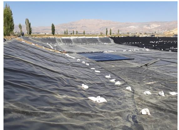
*Étanchéité (géomembrane PEHD) sur talus et fond de casier*
