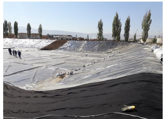
*DRAINTUBE FT sur géomembrane*
