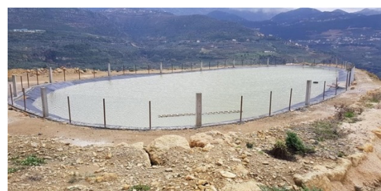
Bassin de rétention pour cultures maraîchères
