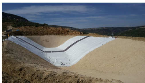
Pose de DRAINTUBE FT sur géotextile
