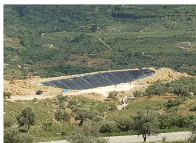
Pose finale de géomembrane sur le bassin
