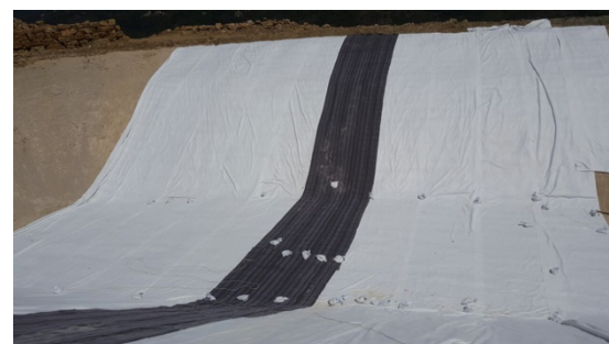
Pose de DRAINTUBE FT sur géotextile
