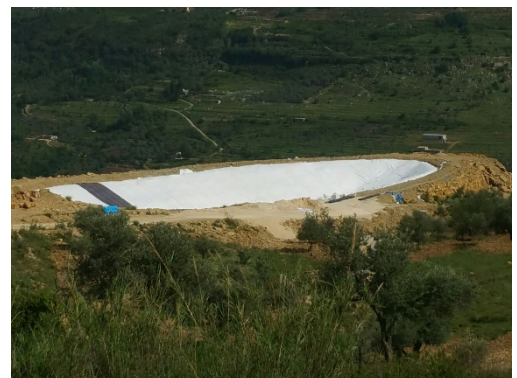
Pose de DRAINTUBE FT sur géotextile
