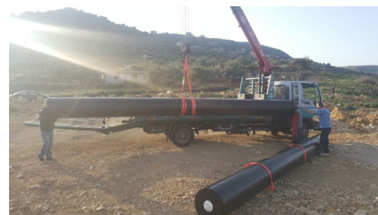
Déchargement des rouleaux de géomembrane
