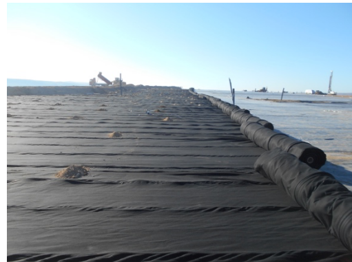
Déroulement de DRAINTUBE FT sur la GCL
