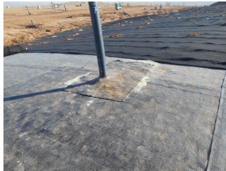
Évent de gaz
