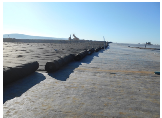
Déroulement de DRAINTUBE FT sur la GCL
