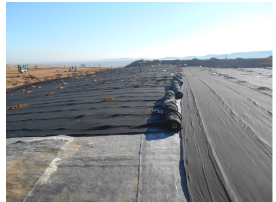
Déroulement de DRAINTUBE FT sur la GCL
