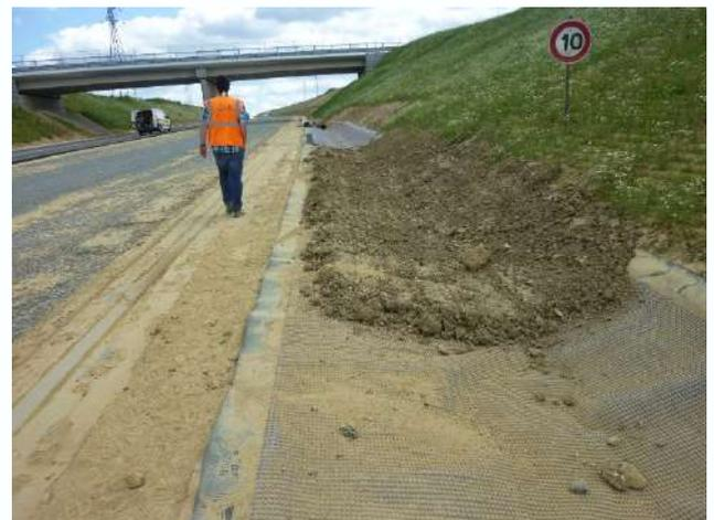
Remblaiement du Stabiliner Alveo (posé en tuile)
