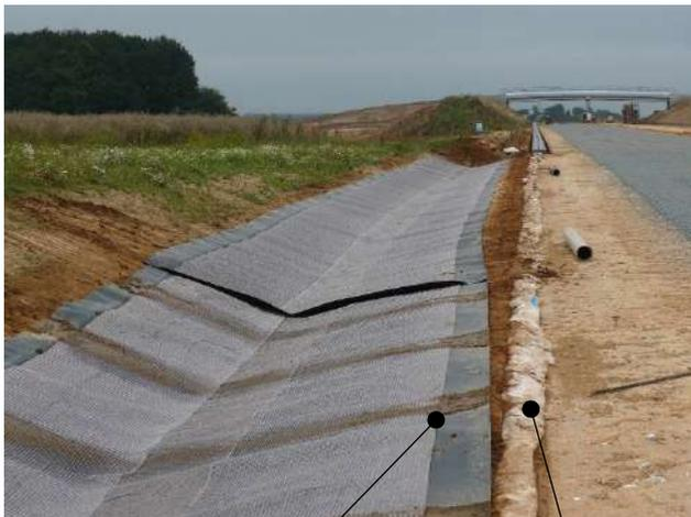
Vue d'ensemble du Stabiliner Alveo et du Draincotex
