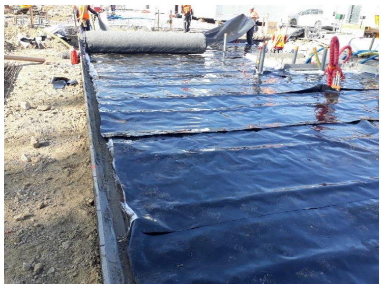
Pose de la membrane EVOH en imperméabilisation
