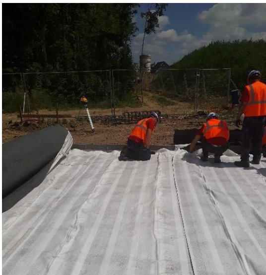
Pose du DRAINTUBE GAZ
