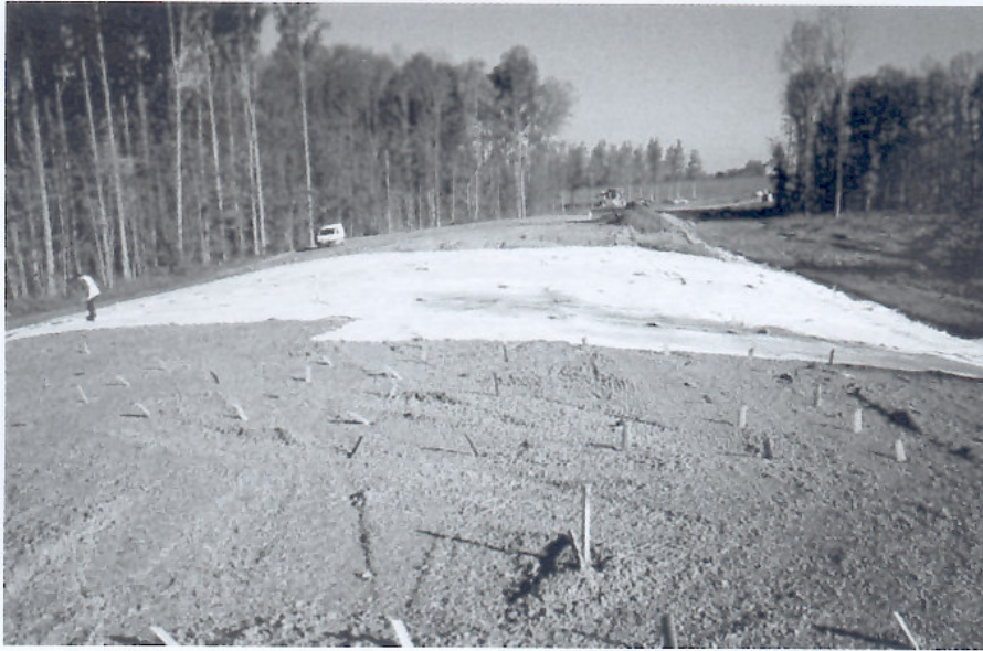
Photo 1. vue des drains verticaux et de la piste d'accès en 'toit'
