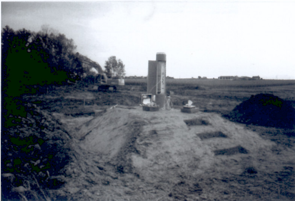
Photo 5. Centrale de mesure
