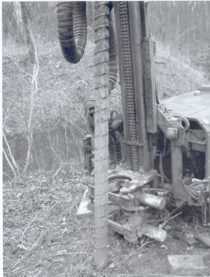
Photo 3. Forage pour la mise en place de l'instrumentation
