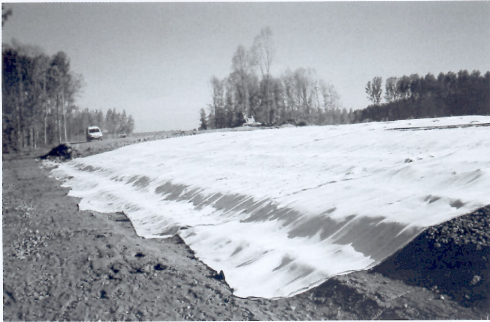
Photo 2. Mise en œuvre du géocomposite de drainage horizontal
