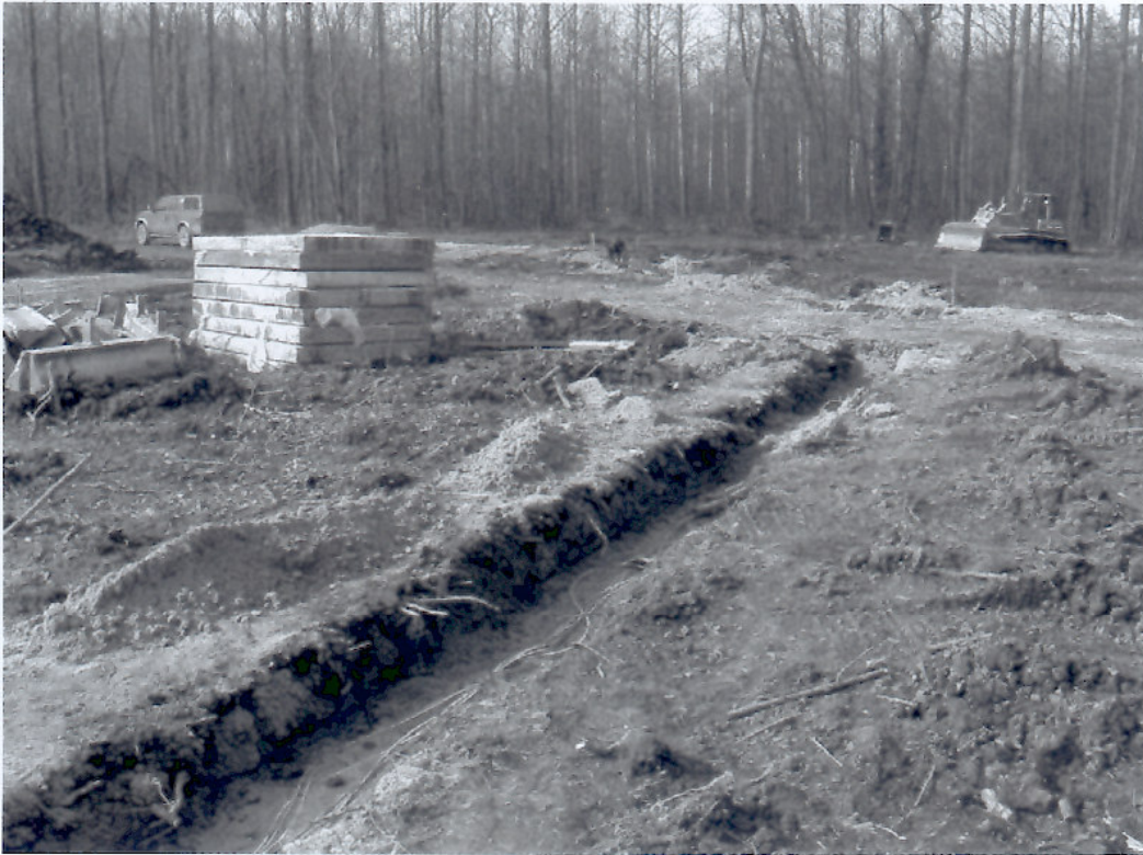
Photo 4. Mise en place de l'instrumentation
