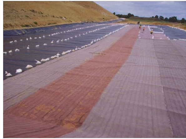
Figure 10. Pose de la géomembrane 2 mm PEHD supérieure.
