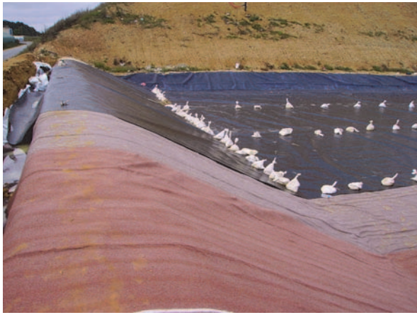
Figure 10. Pose de la géomembrane 2 mm PEHD supérieure.
