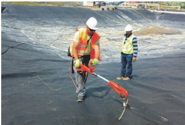
Figure 11. Contrôle de la géomembrane par la méthode du balai électrique
